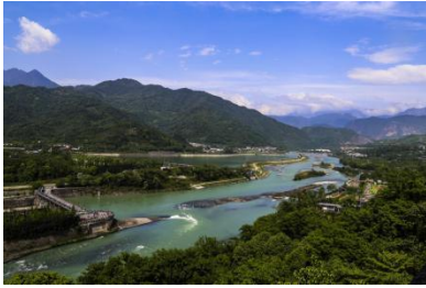
都江堰水利工程
