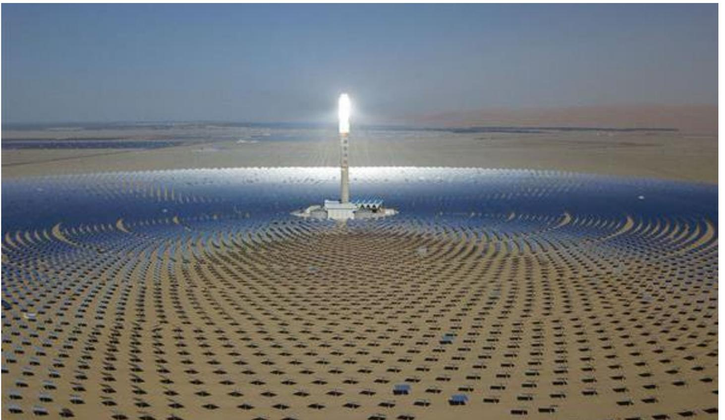
首航节能敦煌 100 兆瓦国家光热示范电站连续不间断运行，首次实现夏季工况下 103 小时昼夜连续发电，发电量超过 390 万度，各项主要指标均达到或优于设计值，电站设备性能正常，运行状态良好。
