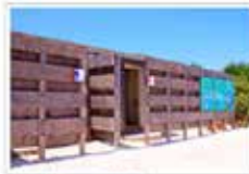
◆ 更衣室，淋浴室
